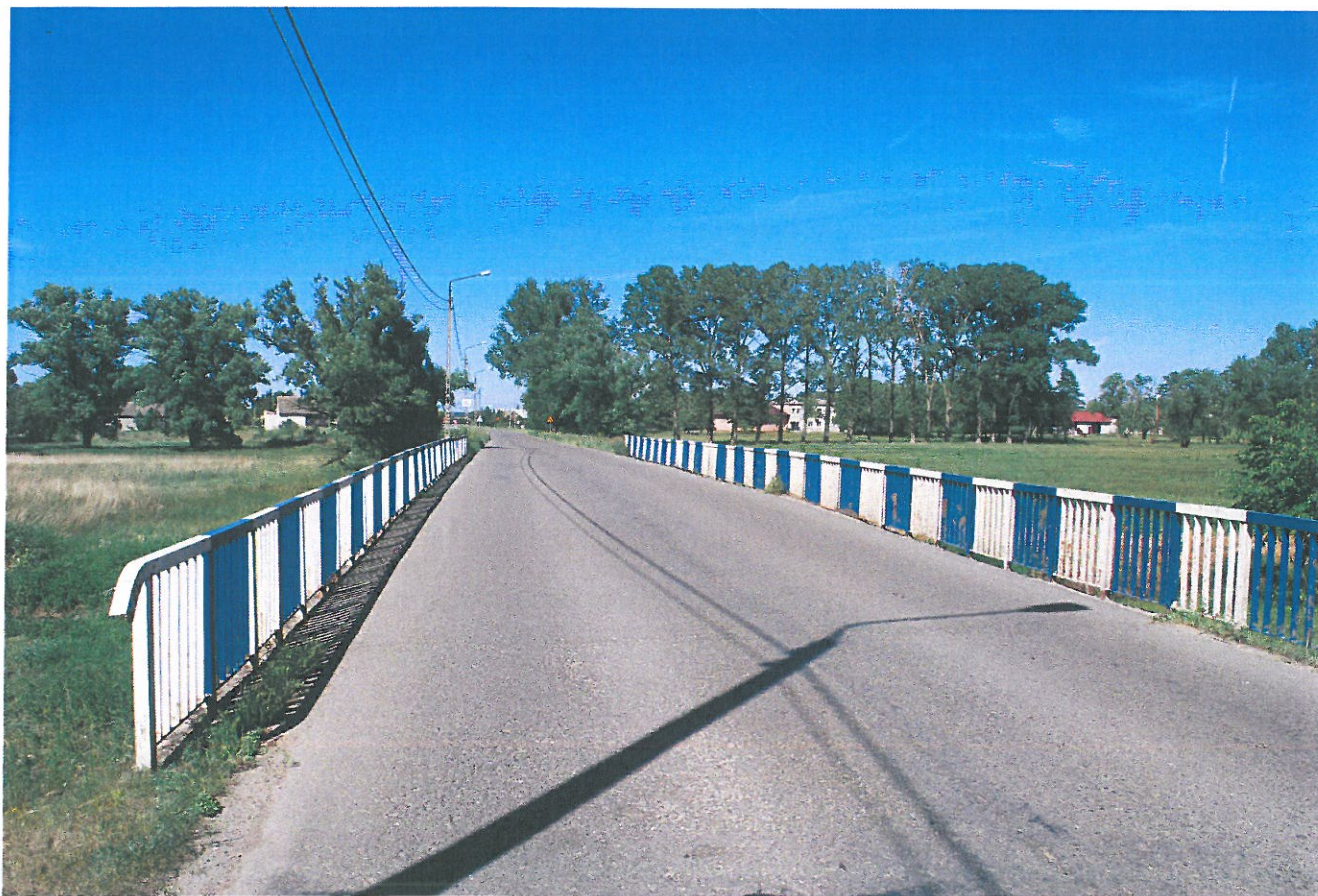
Widok ogólny mostu
