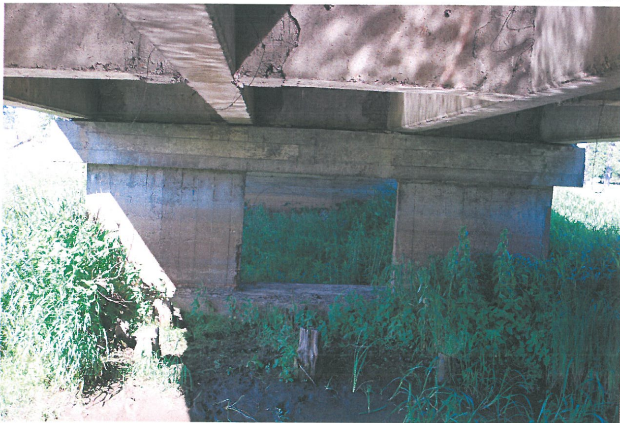
Fot. 26. Wegetacja roślin w przestrzeni podmostowej.
