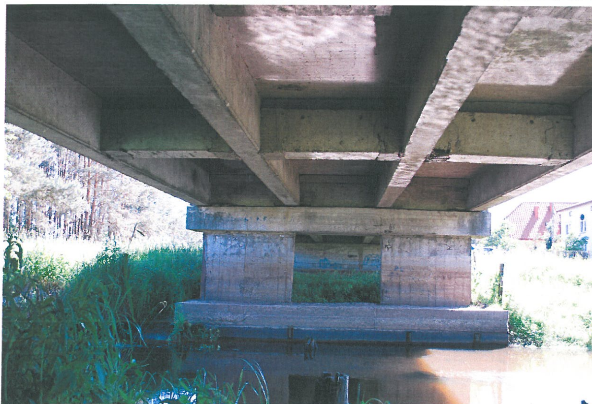
Fot. 2. Widok mostu od spodu
