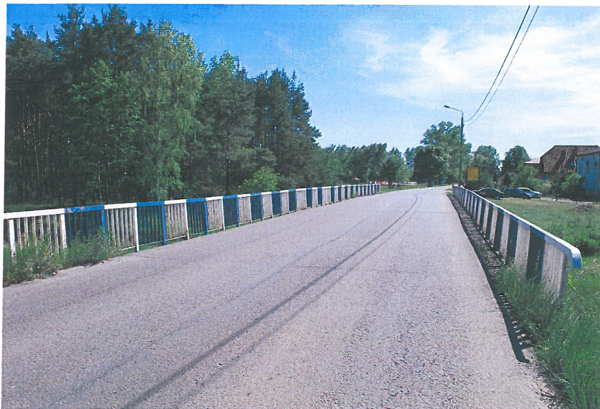
Fot. 1. Widok od strony północnej
